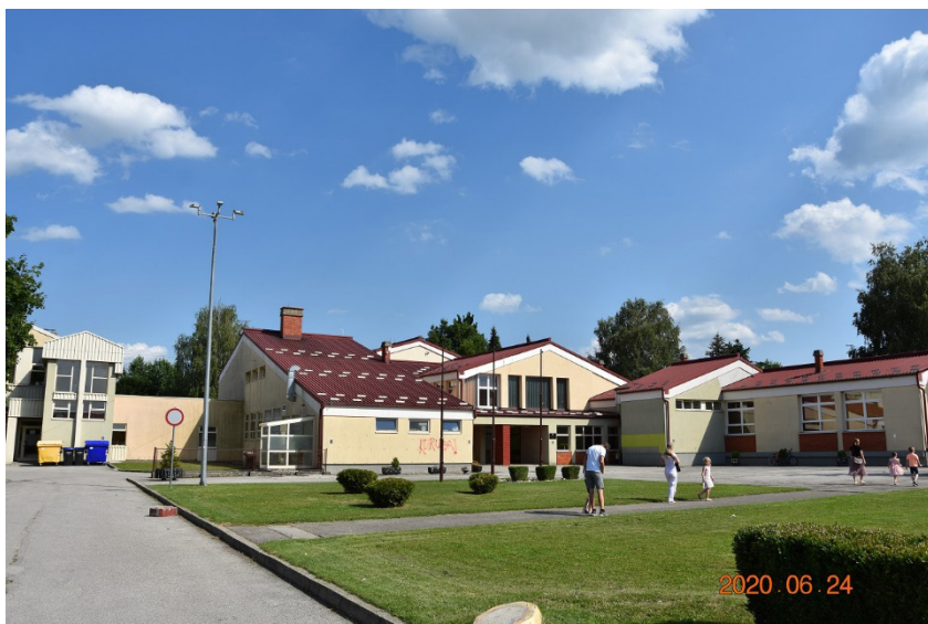
Slika 7. Zgrada škole u naselju Cestica
