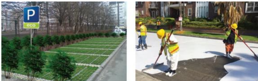
Slika 12. Primjeri zelenog parkirališta i premazivanje kolnika svijetlim bojama, koje reflektiraju Sunčevu toplinu (izvor: časopis Građevinar 9/2019)
