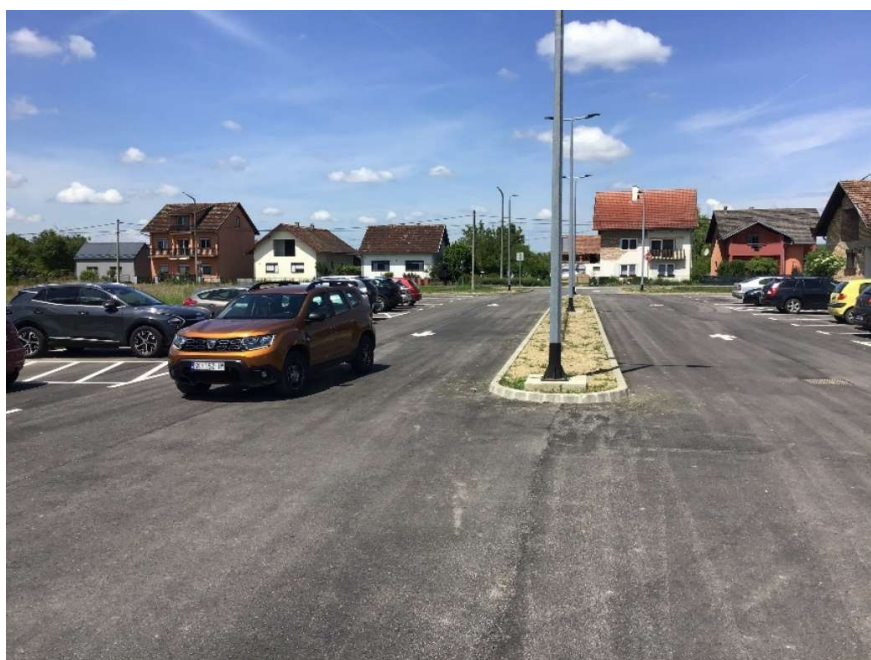
Slika 42. Izgrađeno novo parkiralište ispred Osnovne škole Sunja
