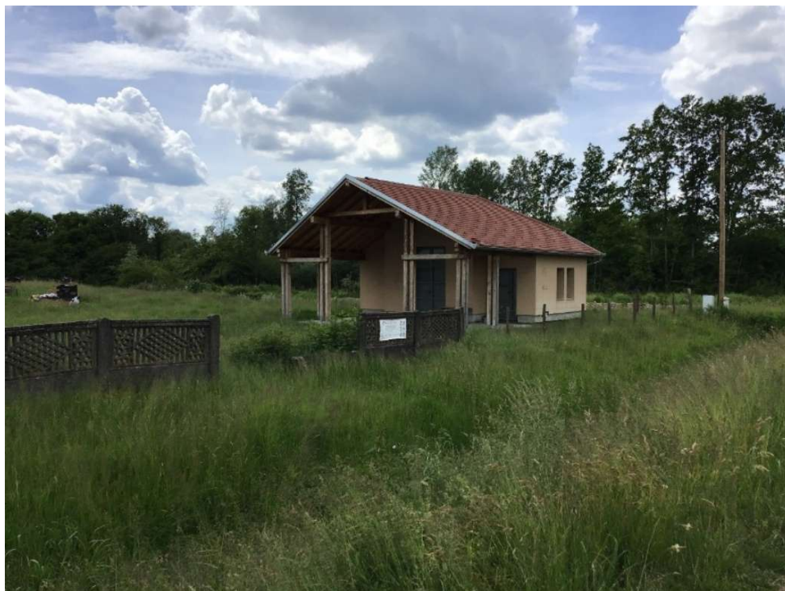
Slika 48. Izgradnja mrtvačnice u Crkvenom Boku Izvor: ZPUSMŽ
