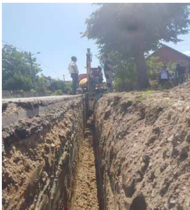
Slika 17: Izgradnja komunalne infrastrukture
