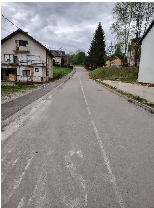
Slika 50. Izgrađena prometnica Novo naselje Izvor: ZPUSMŽ
