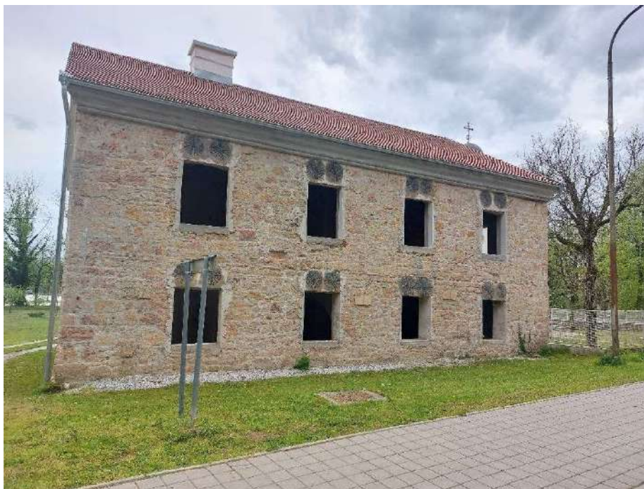
Slika 46. Započeta obnova nakon potresa parohijskog doma Izvor: ZPUSMŽ
