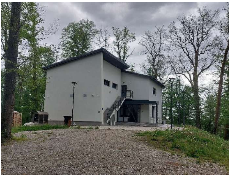
Slika 47. Obnovljena je Vila Zelengaj Izvor: ZPUSMŽ
