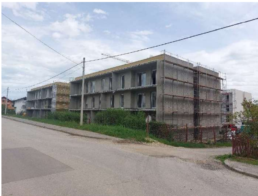
Slika 44. Započeta izgradnja višestambenih zgrada u okviru OPKK projekta Izvor: ZPUSMŽ
