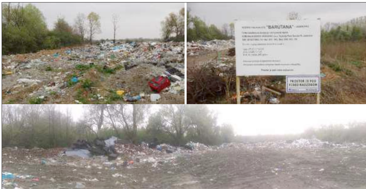
Slika 5.3.: Postojeće stanje na lokaciji odlagališta Barutana
